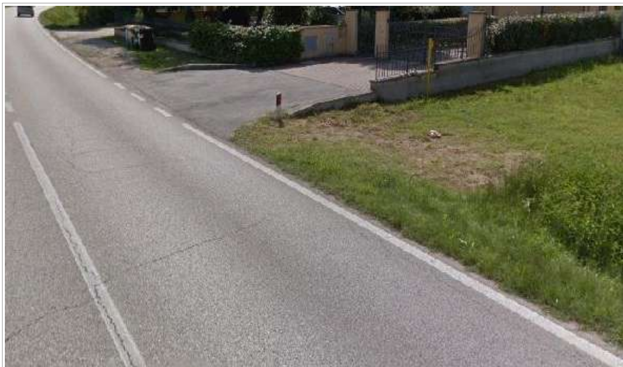
Fig. 27 – Esempio di tombinamento del fosso stradale con adeguato raccordo alla carreggiata e arretramento del sistema di chiusura con idonea area di stazionamento pavimentata.
